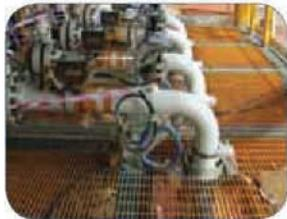
Система устанавливаемых датчиков Rightrax™ обеспечивает постоянный мониторинг утонения стенок при воздействии песчаной эрозии на ответственные элементы добывающих платформ.
